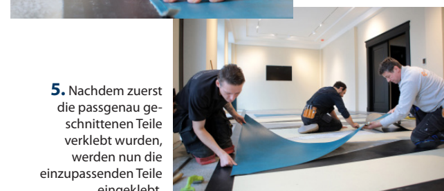
Das Linoleum für den Rautenboden im Verbindungsflur wurde auch von Hand zugeschnitten.
