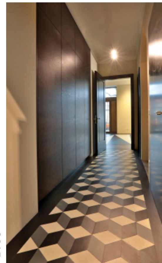
Das Linoleum für den Rautenboden im Verbindungsflur wurde auch von Hand zugeschnitten.
